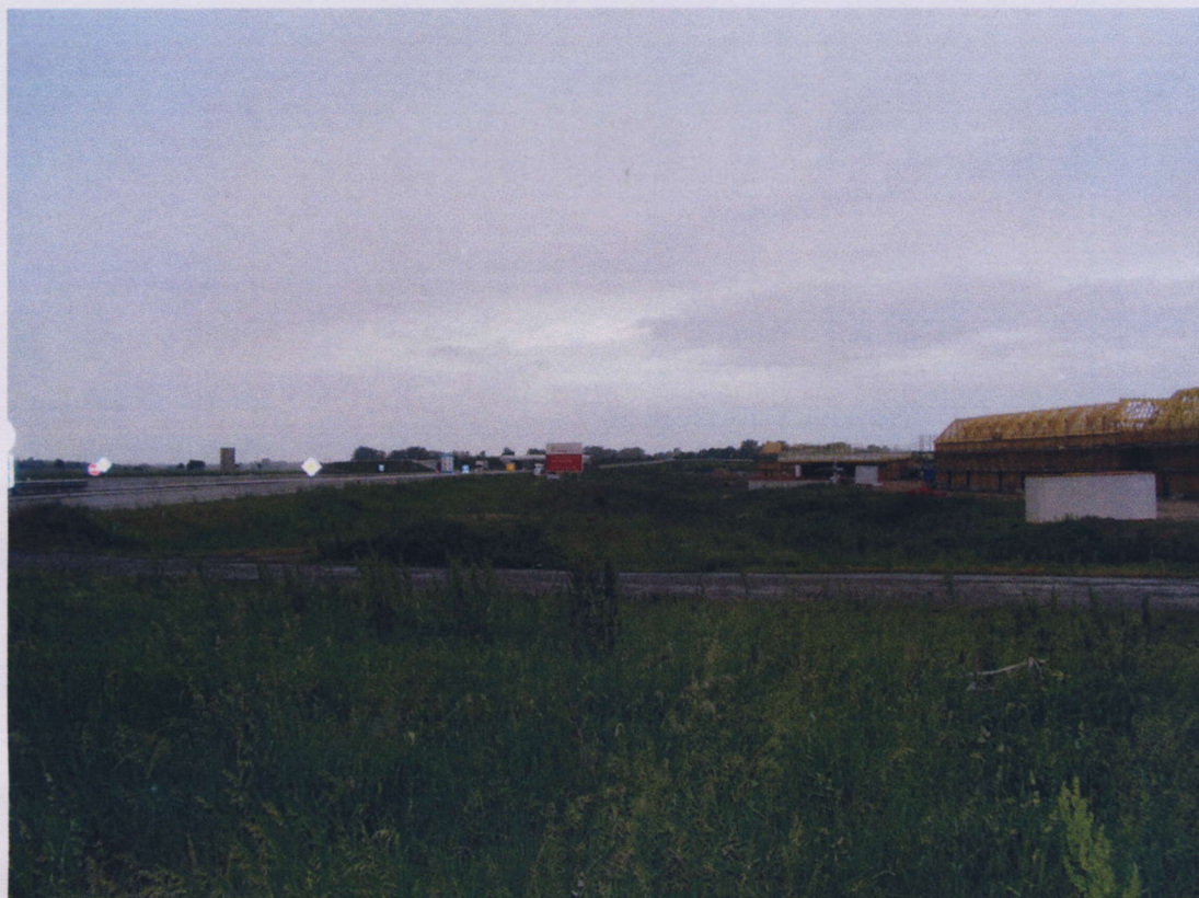
Shopping Outlet Roppenheim mit Straßen- und Brückenbauwerken am 14.05.2011
