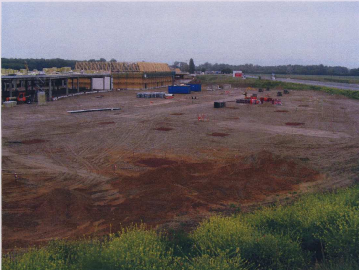
Baustelle FOC am 14.05.2011
